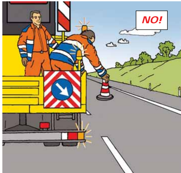
Figura 60 – Posizionamento dei coni o defleco: comportamento scorretto
