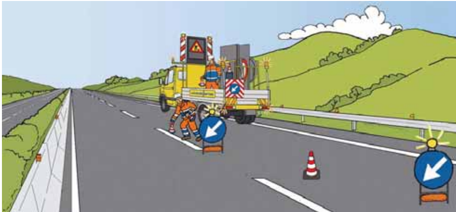
Figura 50 – Chiusura della corsia di marcia: inizio della posa dei coni
