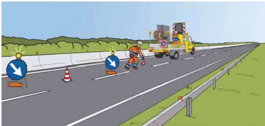
Figura 57 – Chiusura della corsia di sorpasso: inizio della posa dei coni
