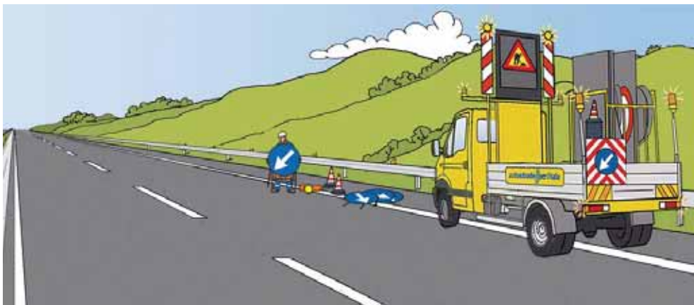
Figura 49 – Chiusura della corsia di marcia: scarico della segnaletica di testata sul margine destro
